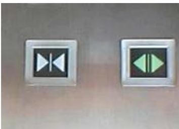
これが現場の開閉ボタンだ！左のボタンを押すとドアは閉り、右を押すと開く仕組みとなっている。それは何処で判断されるのかというと、三角印は矢印のようなメッセージになっており、先が鋭い方がドアの動く方向を示している。これを「矢印もどき」とでも命名しておこう。（矢というのは本来、「柄」と「矢じり」を組み合わせであるもので（例：→）、
